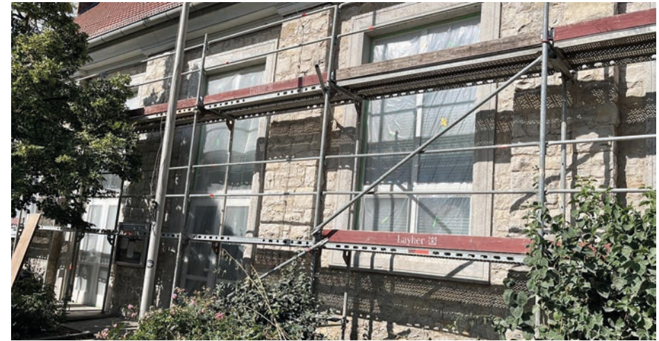
Gerüst an der Längsseite der TVO-Halle
