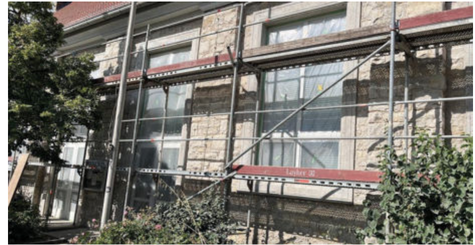
Gerüst an der Längsseite der TVO-Halle
